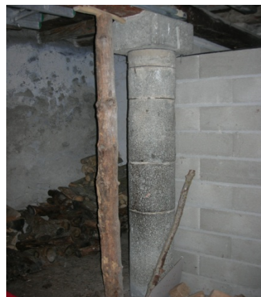
Columna que sujeta el piso superior
