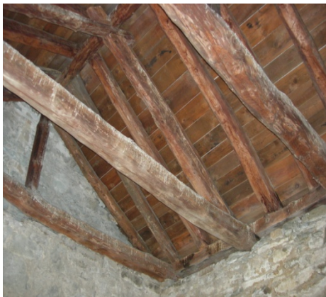
Techumbre de la Torre-Campanario
